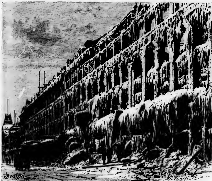
STALACTITES DE GLACE SUR LA FAÇADE D'UNE MAISON ENFONDÉE.
